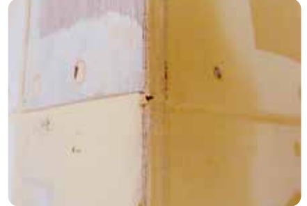
合板での施工
